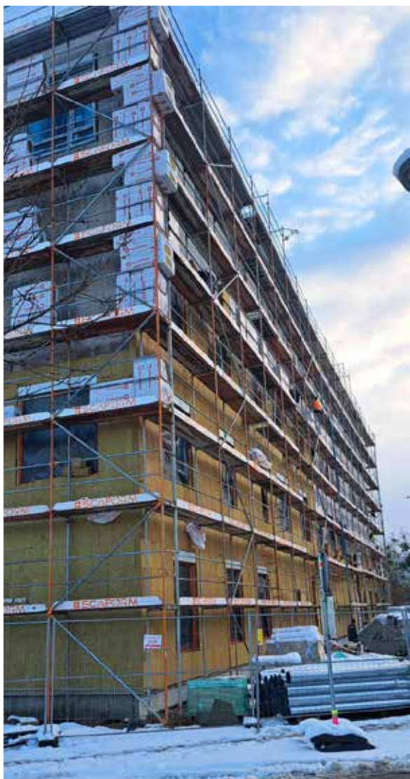
Budowa Centrum Stomatologii, listopad 2025 r.
