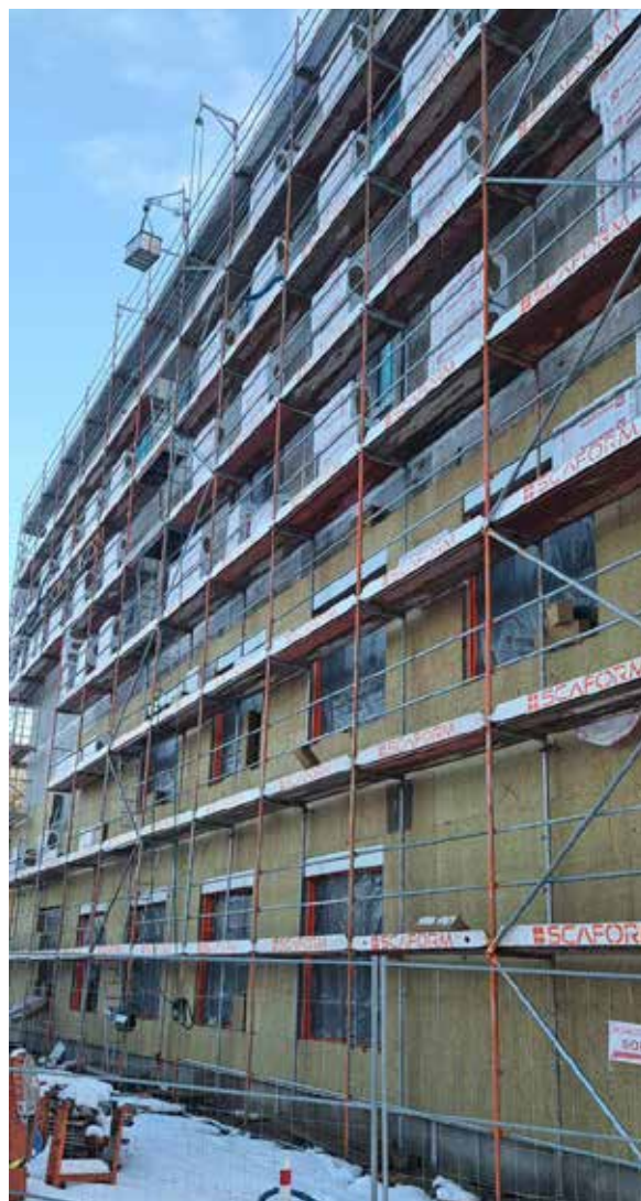
Budowa Centrum Stomatologii, listopad 2025 r.
