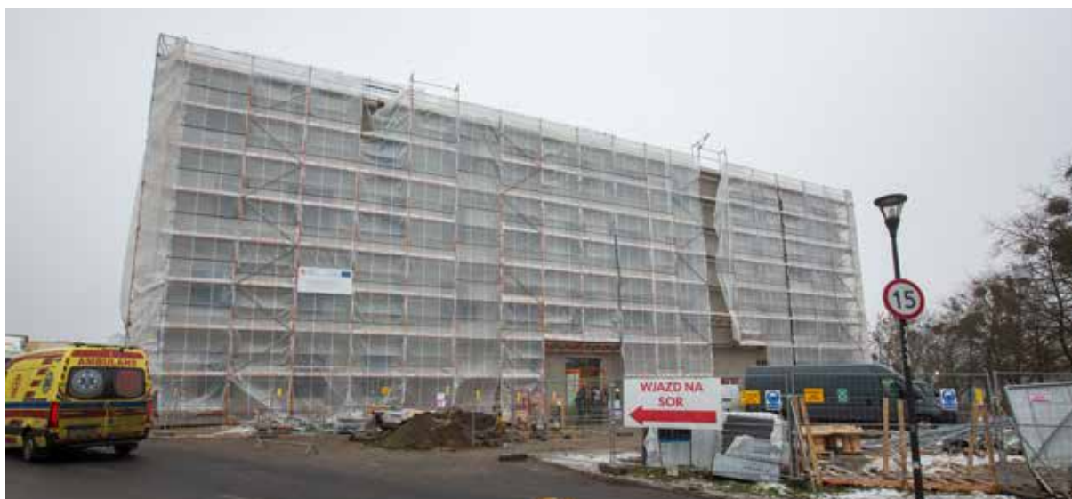
Budowa Centrum Stomatologii trwa
