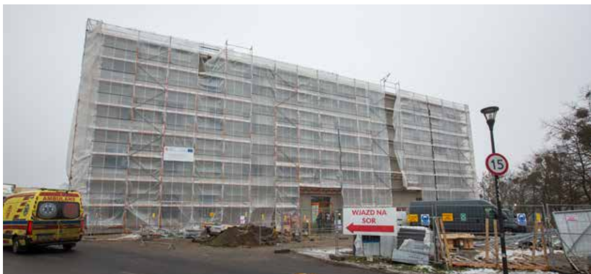
Budowa Centrum Stomatologii trwa
