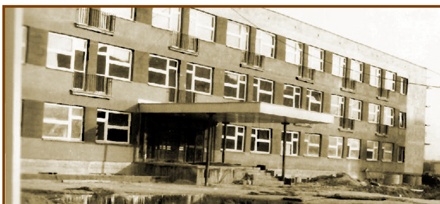
Wejście główne budowanego Szpitala Wojewódzkiego im. dr. J. Biziela w Bydgoszczy
