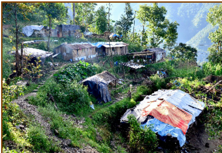
Tymczasowe domy Sindhupalchowk, 2015
