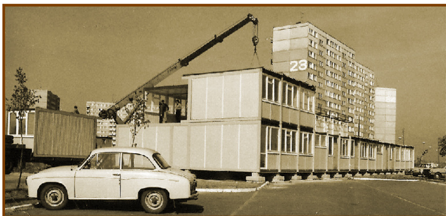
Podczas budowy Szpitala Wojewódzkiego im. dr. J. Biziela w Bydgoszczy
