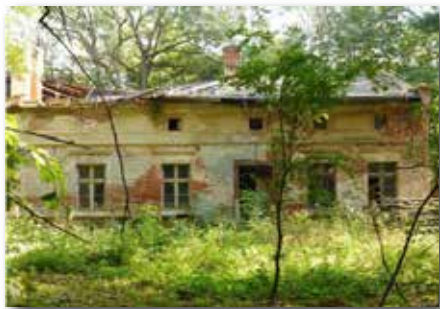
Ryc 3. Dusocin – dom rodziny Rydygierów w Dusocinie, gdzie na świat przyszedł w roku 1850 Ludwik Rydygier, stan sprzed remontu (fot. A. Jawień)
